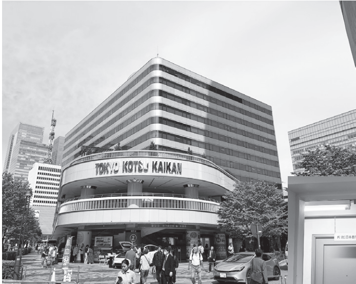
東京交通会館外観
